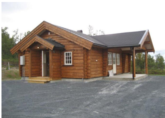
Bilder av Lenningshytta, ferdigstilt i september 2014:
